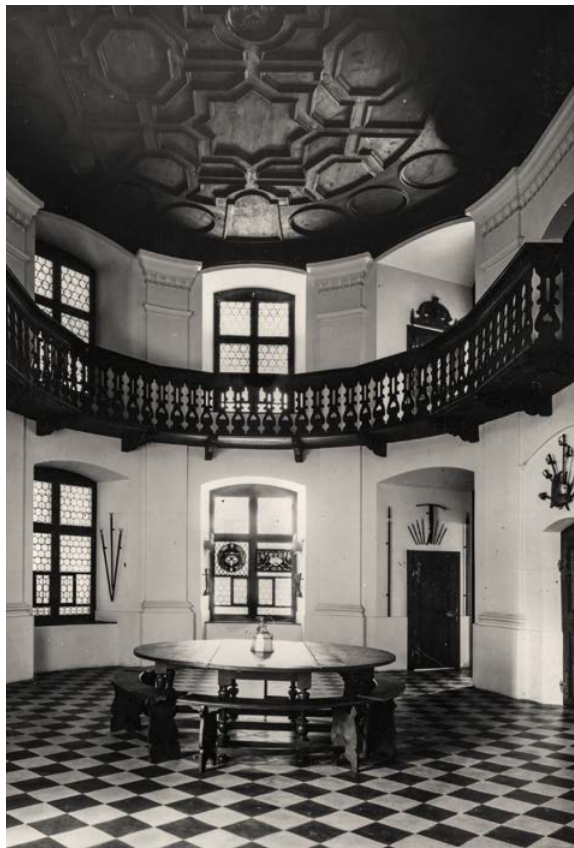
Der ehemalige Rittersaal wurde später in die Marienkapelle umgebaut, die nun ebenfalls der Vergangenheit angehört.
